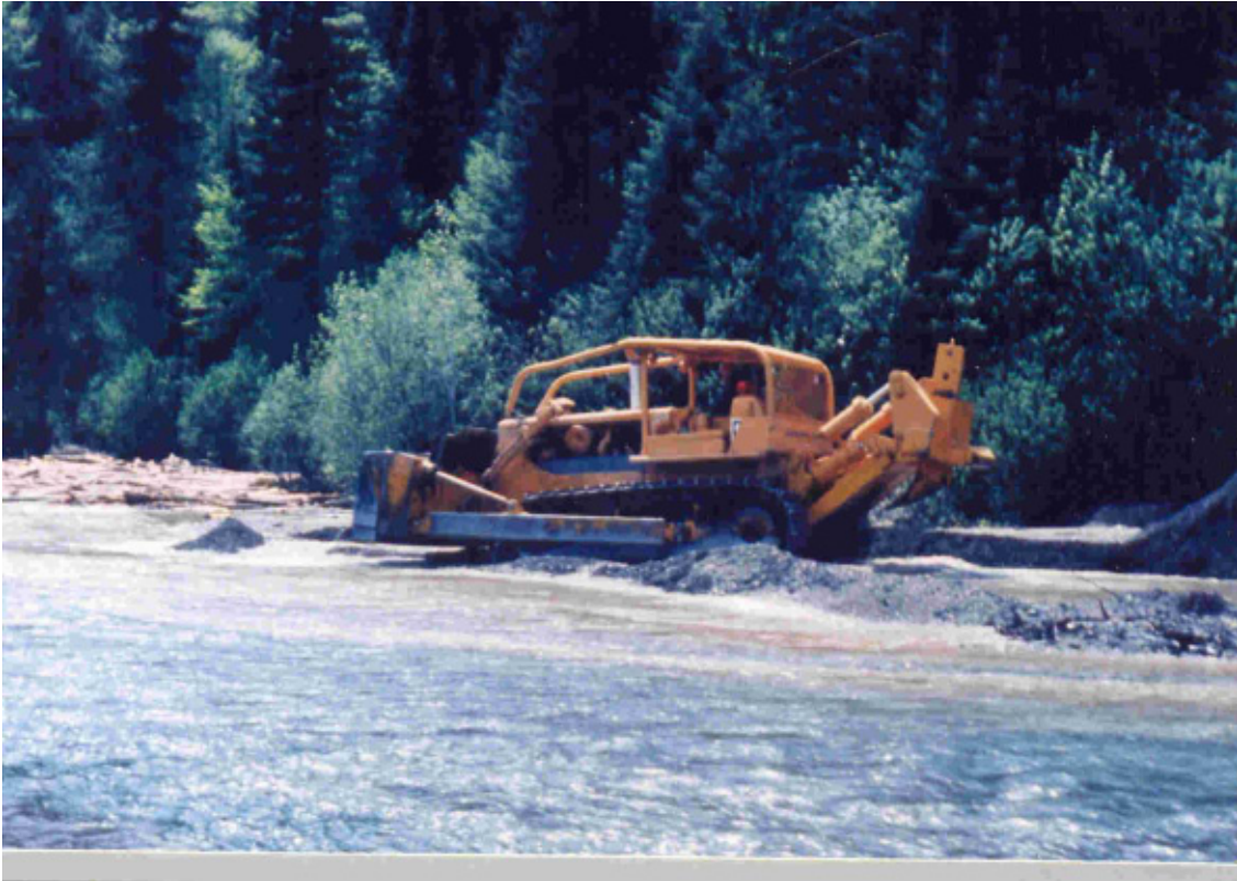
Bulldozer travaillant à pousser des billots plus loin vers le cours d'eau.
