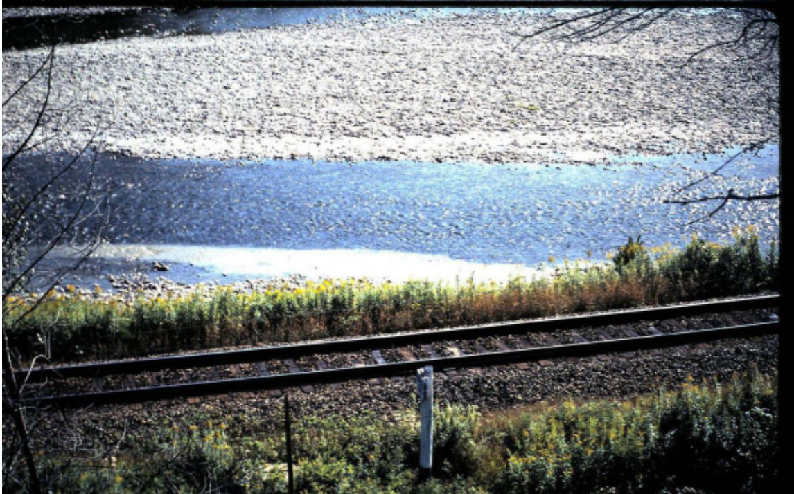
Eaux usées s'écoulant dans la rivière Matapédia par un tuyau qui passe sous la voie ferrée en amont du site de déversement
