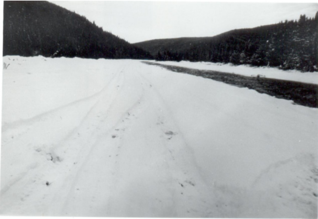
La rivière Nouvelle (30 milles à l'est de Matapédia) après un réaménagement au bulldozer
